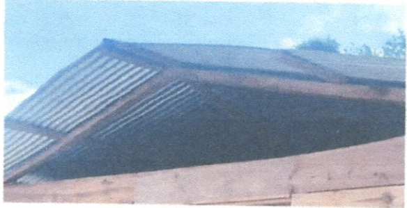
Foto 2: Techo con pandeo, inestable, lados abiertos, inseguro
