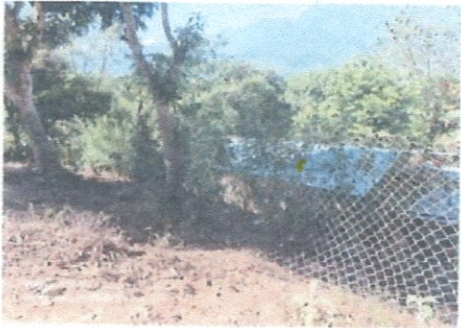
Foto 5:cerco perimetral en mals condiciones, se considera un peligro para la integridad física de los alumnos
